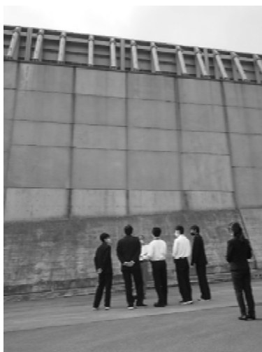
【防潮堤について説明を受ける】
