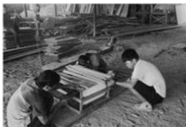
現地での雨水タンク作成
