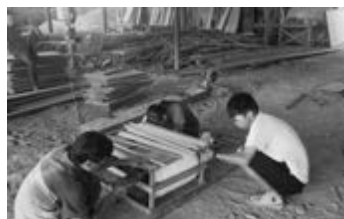
現地での雨水タンク作成
